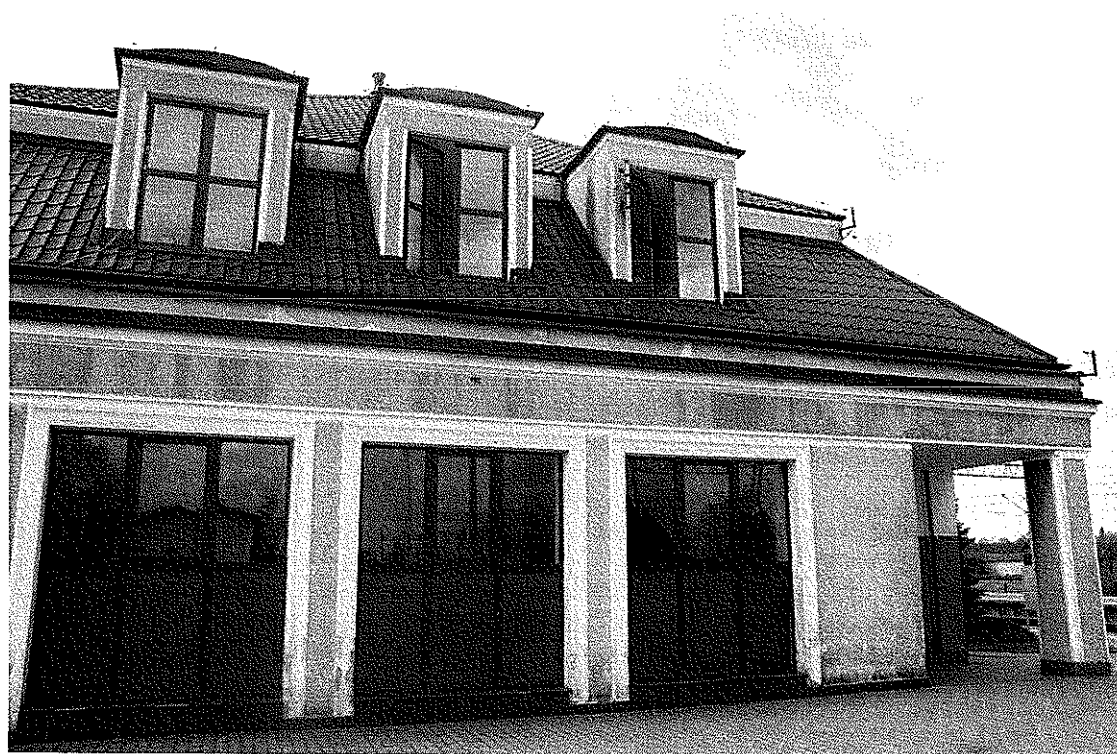
Fot. 2. Elewacja wschodnia
