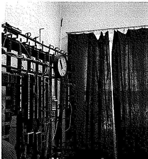
Fot. 7. Pomieszczenie prywatnej firmy – serwerownia
