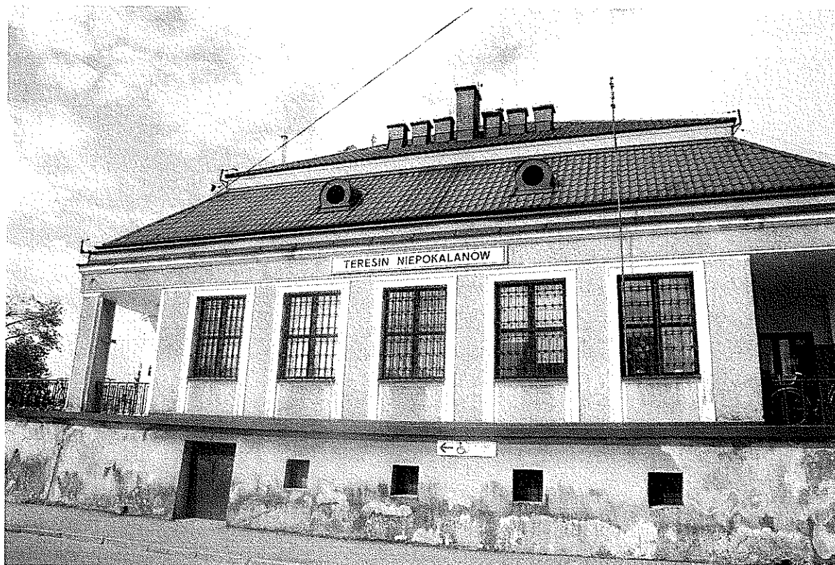
Fot. 3. Elewacja południowa
