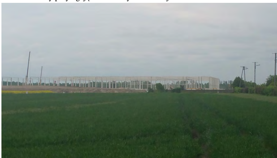
Fot. 12. Budowa wielkopowierzchniowych obiektów magazynowych od strony południowej.
