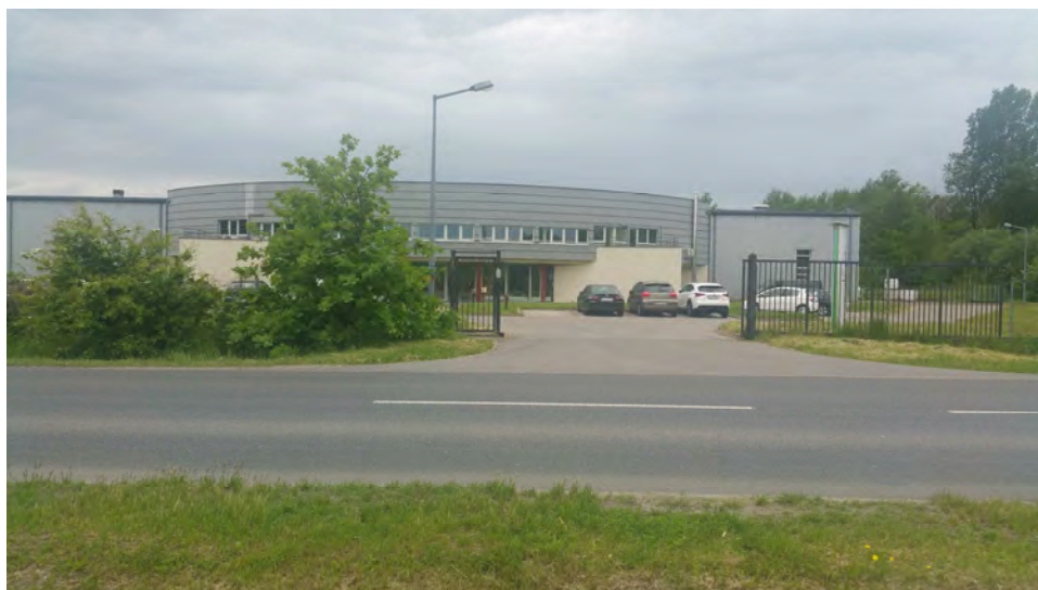
Fot. 9. Obiekt usługowy przy Trakcie św. Jana Pawła II.
