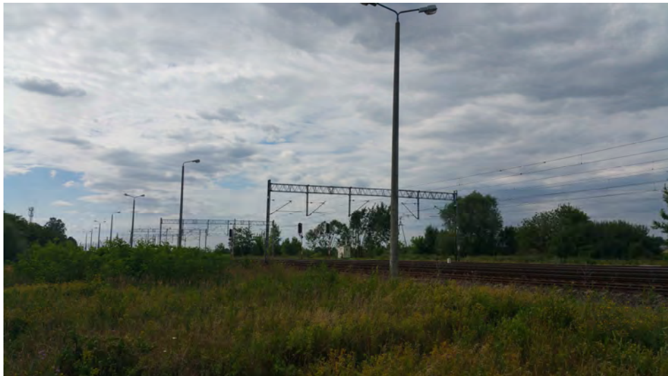
Fot. 10 Linia kolejowa.
